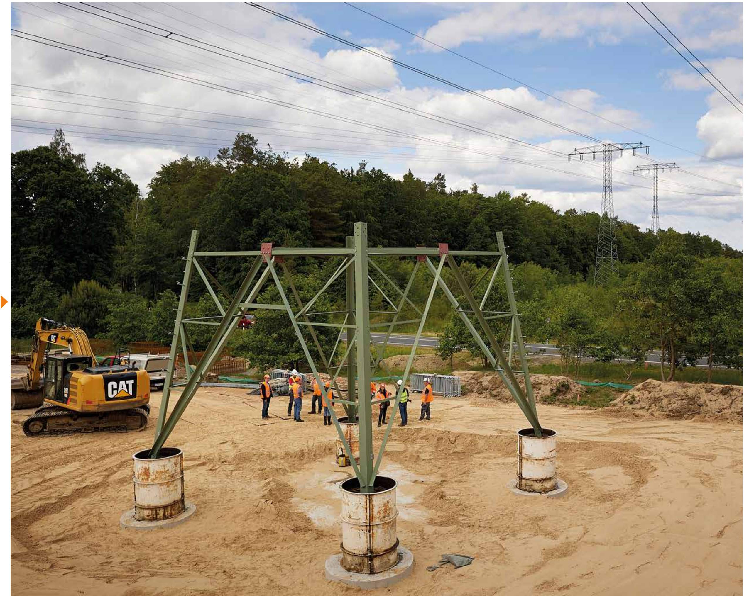
Mastfuß nahezu fertiggestellt, Schalung für das Gießen der Fundamentköpfe vorbereitet
