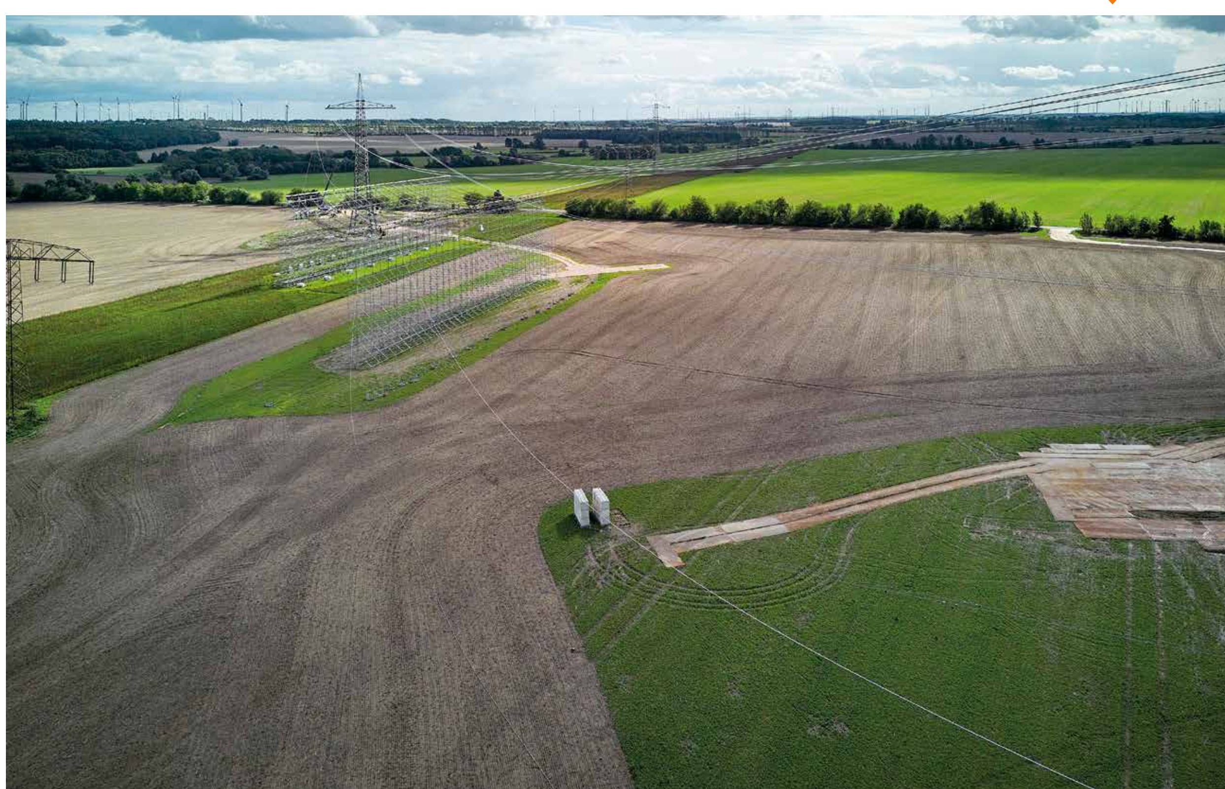
Seilzug über einer Leitungskreuzung mit Schutzgerüst
