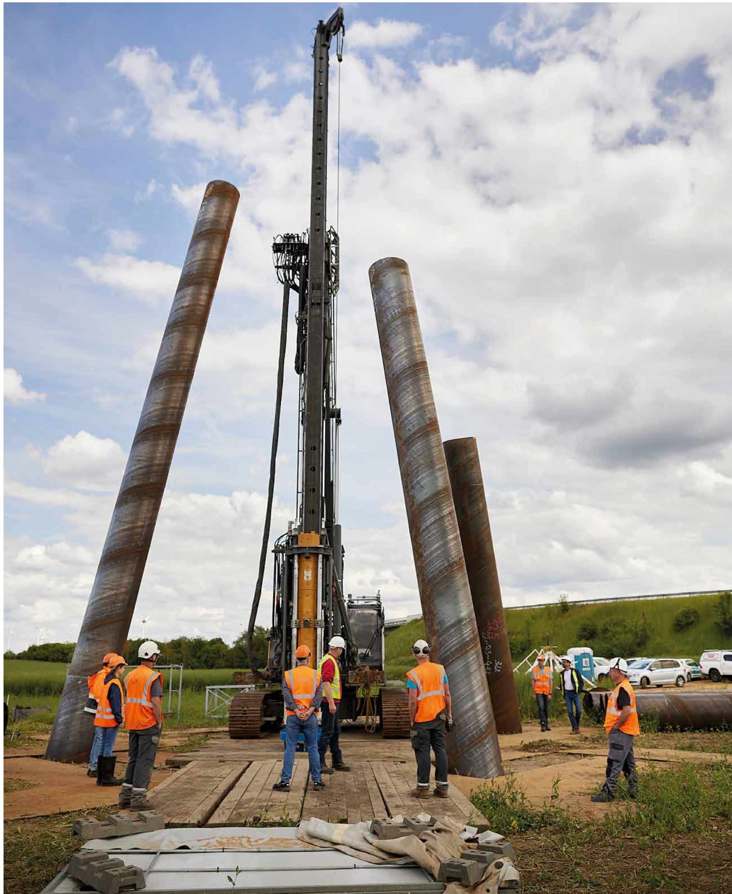
Errichtung der Bohrpfähle eines Tiefenfundaments
