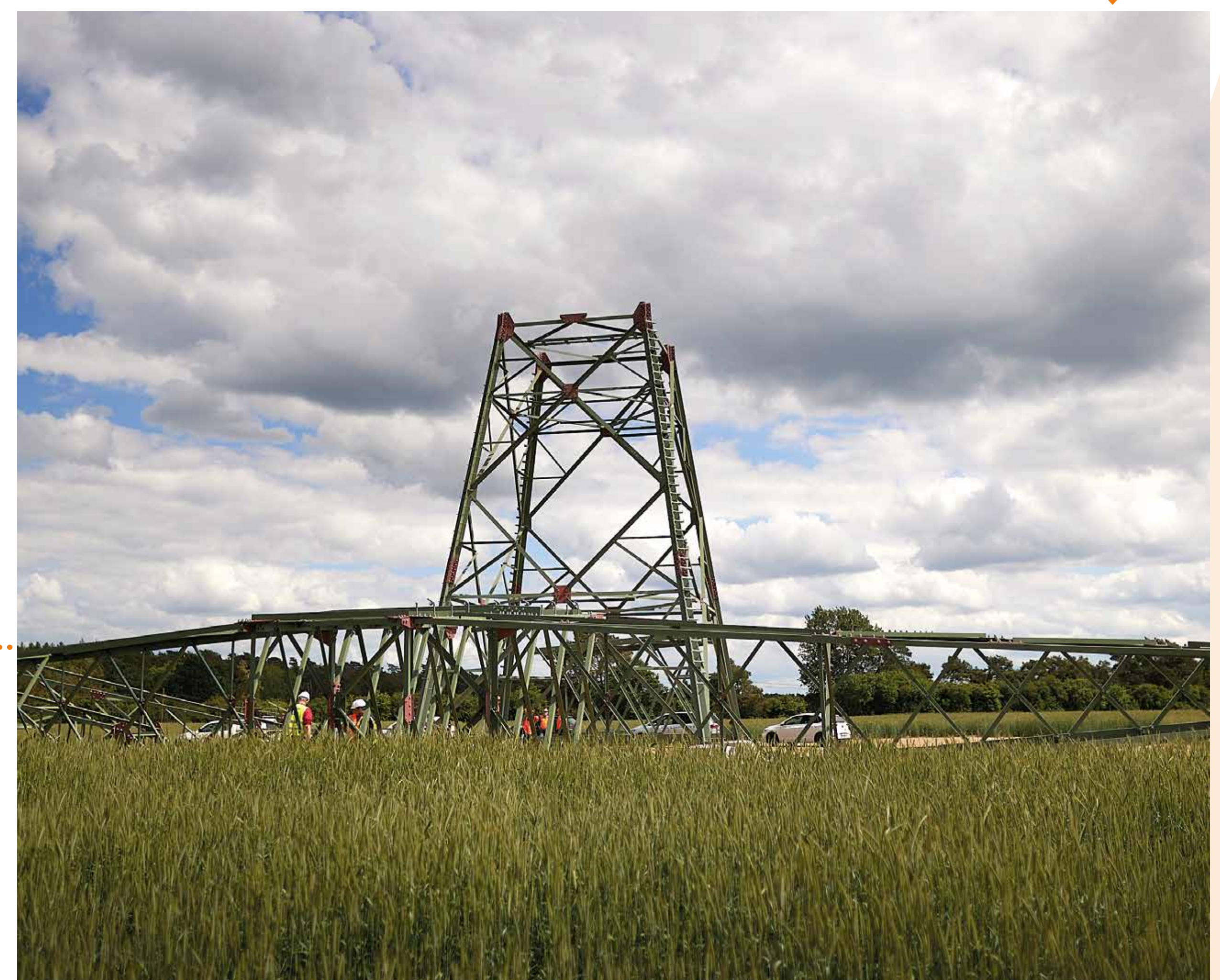
Mast teilweise gestockt, vormontierte Mastteile im Vordergrund
